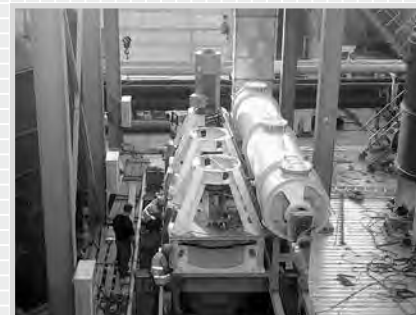
Монтаж утфелераспределителя ТУР4 на Буинском сахарном заводе / Installation of TUR4 masecuite distributor at Buinsky Sugar Refinery
