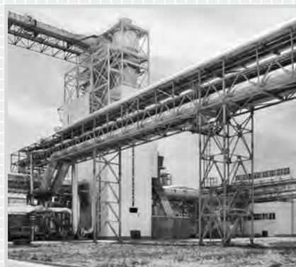
Металлоконструкции для Коростенского завода МДФ (Украина) / Steel Structures for Korosten MDF Plant (Ukraine)
