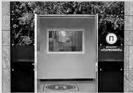
ЦОД “Парковый” / Parkoviy Data Center
