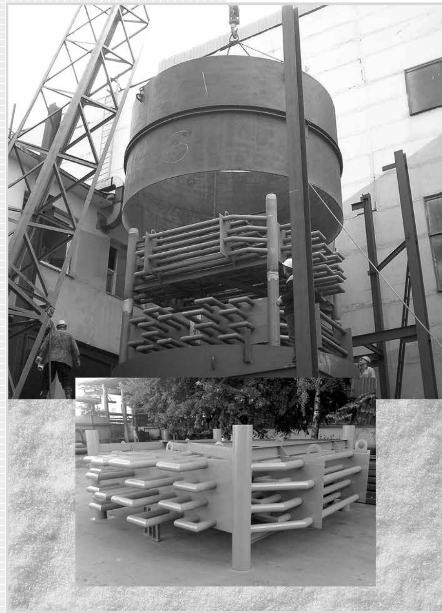
Монтаж ТКВ / Installation of Vertical Crystallizer mod. TKV
