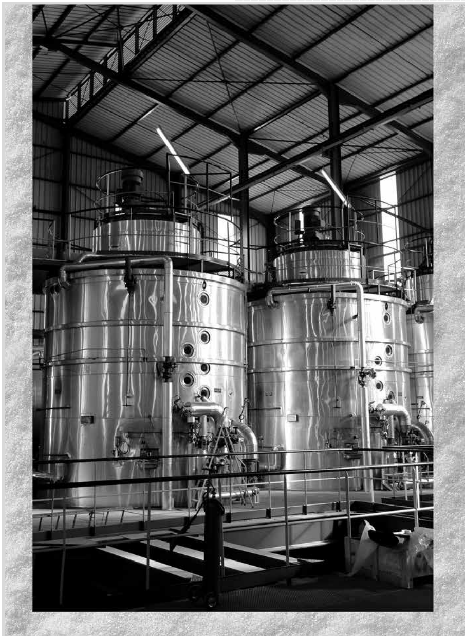
Вакуум-аппараты ТВА в Алжире / TVA Batch Pans in Algeria
