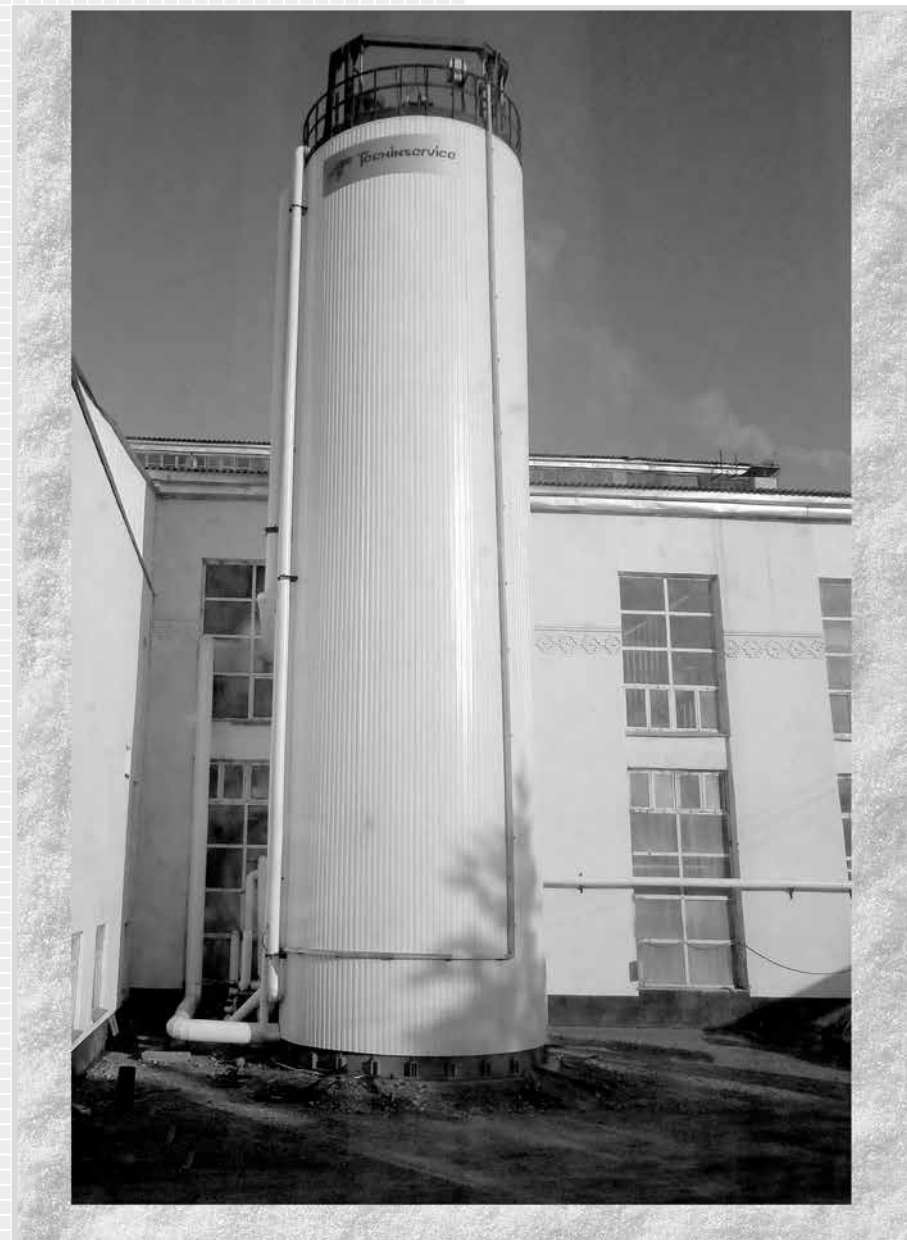
Вертикальный кристаллизатор ТКВГ-340 (Курганский с. з.) / Vertical Crystallizer mod. TKVG-340 (Kurganinsk Sugar Factory)
