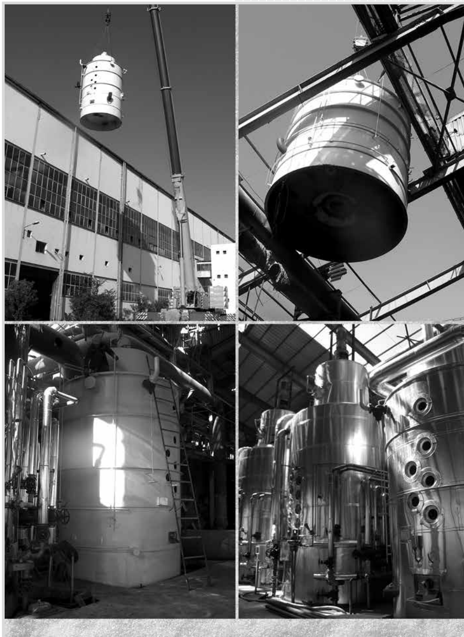
Монтаж вакуум-аппаратов на действующем сахарном заводе в Гуэлле (Алжир) / Installation of vacuum pans at Guelma Sugar Refinery (Algeria)
