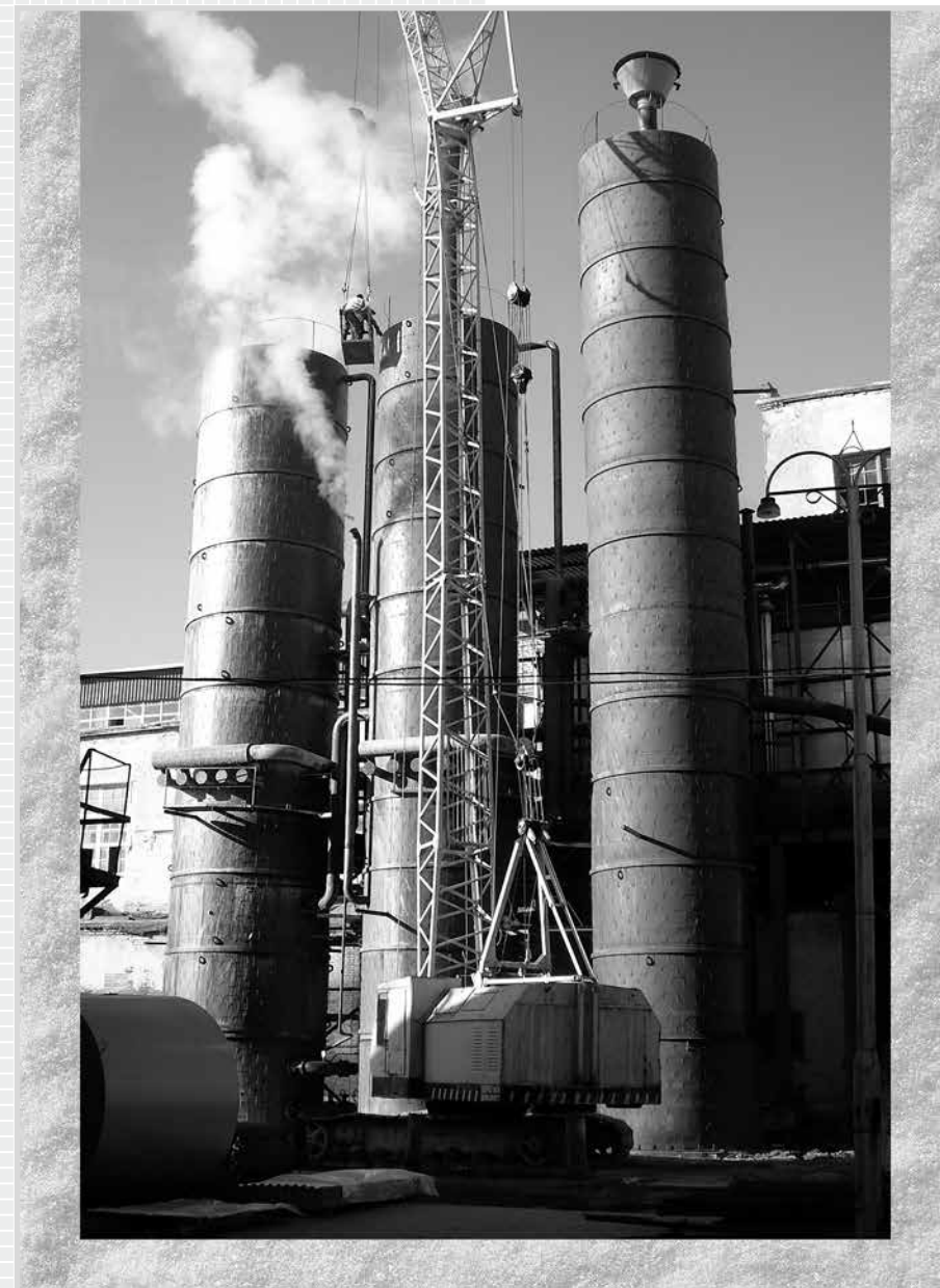
Станция дефекосатурации (Чернянский с.з., ГК "Русагро") / Purification station (Chernyansky Sugar Plant, Rusagro Group)
