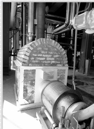
Камера догорания сернистой печи / Sublimation chamber of the sulfur burner
