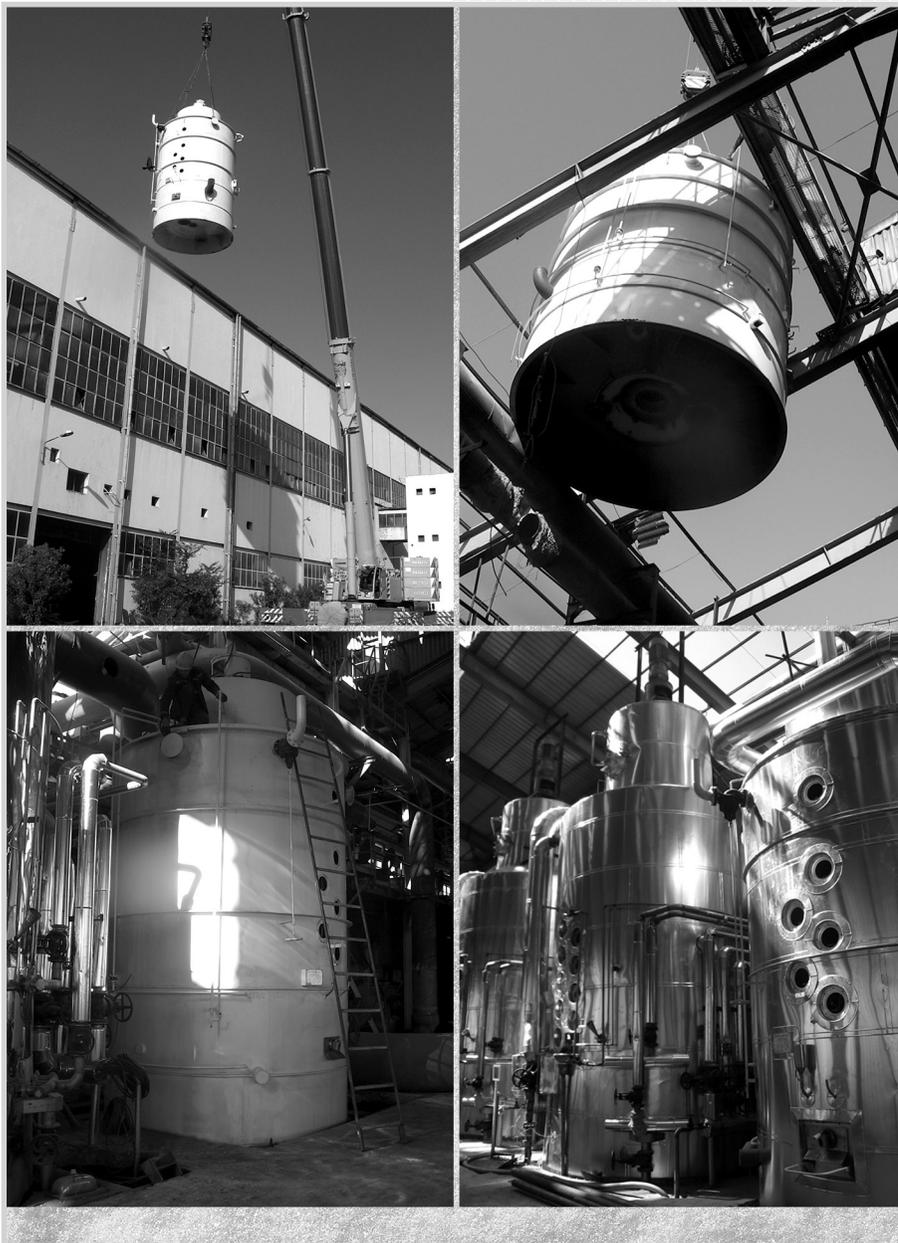
Монтаж вакуум-аппаратов на действующем сахарном заводе в Гуэлма (Алжир) / Installation of vacuum pans at Guelma Sugar Refinery (Algeria)
