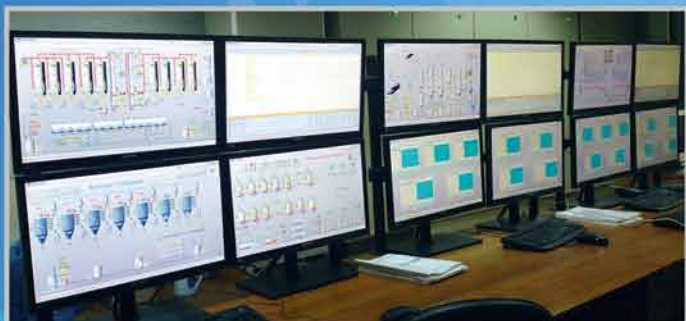
Операторская ЦДП на Гайсинском сахарном заводе
