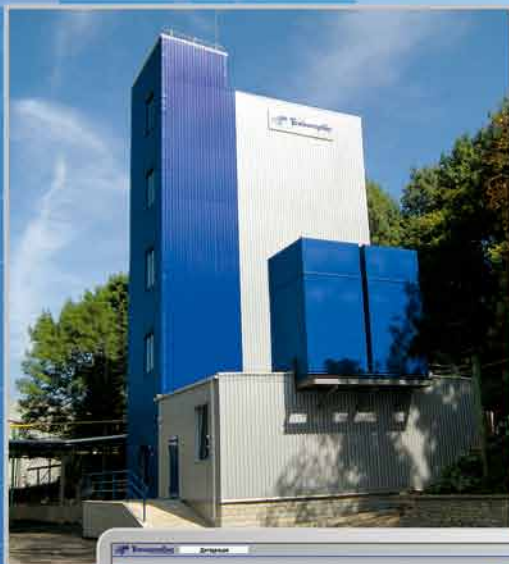
Станция дегидратации спирта (производство биоэтанола)
