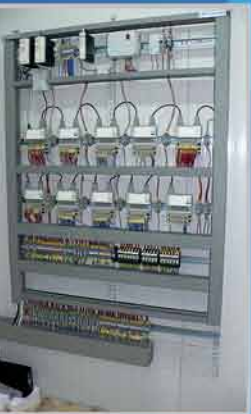
Монтаж щитовой САУ продуктового отделения сахарного завода
