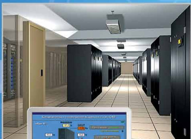
Машинный зал ЦОД "Парковый"
