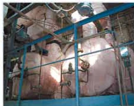
Перевод котла БКЗ-50-39Ф на сжигание ВУТ. Разработчик – "Техинсервис"
