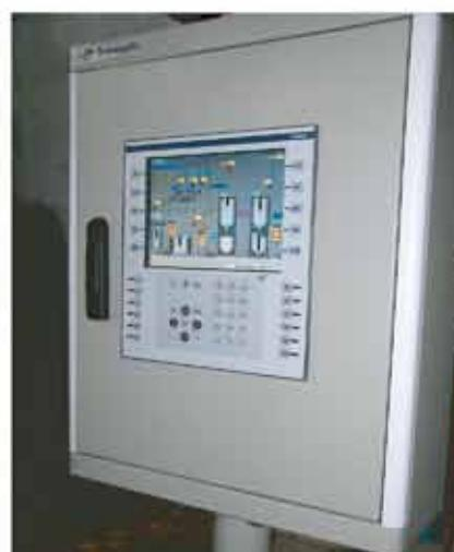
Операторская панель управления станции дефекосатурации
