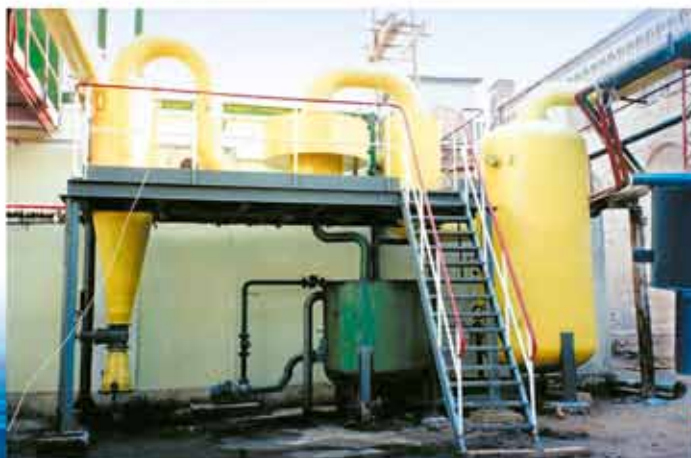
Станция очистки газа
